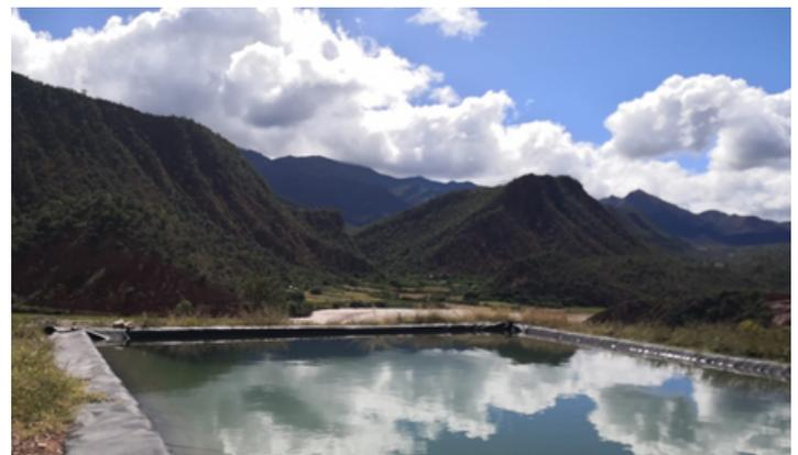
**Réservoir permettant une gestion plus souple du tour d'eau et la mise sous pression**
